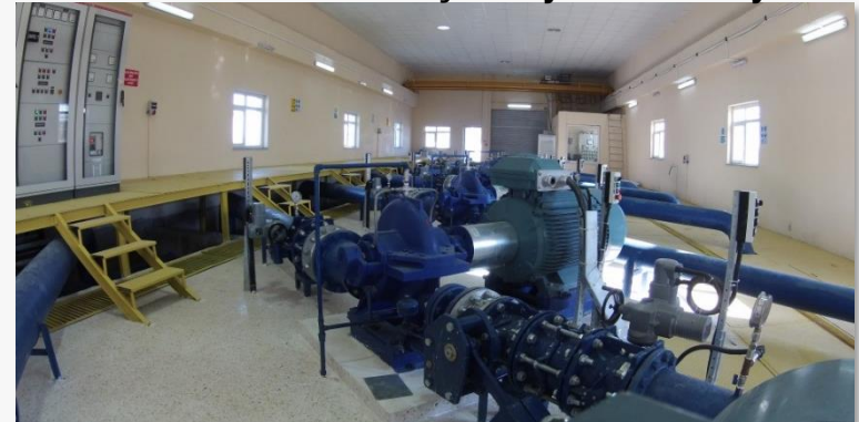
Sivas İçmesuyu Terfi İstasyonu
